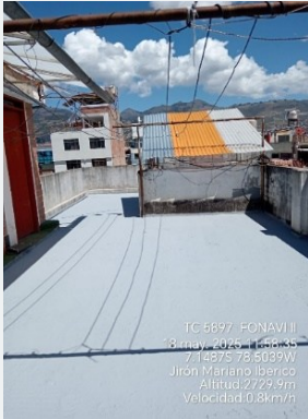
DESPUES IMPERMEABILIZACION
