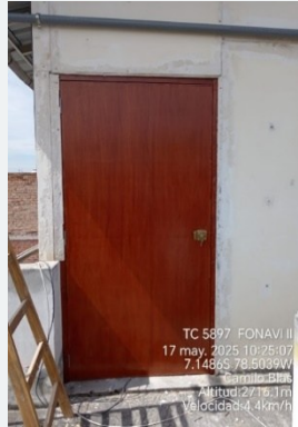
DESPUES CERRADURA Y PUERTA
