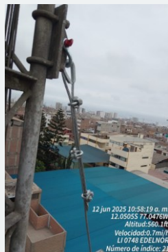
DESPUES DE LA INSTALACION DE GRAPAS Y VIENTOS
